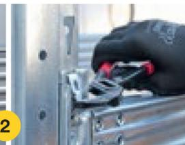
3. Clip korrekt montiert
